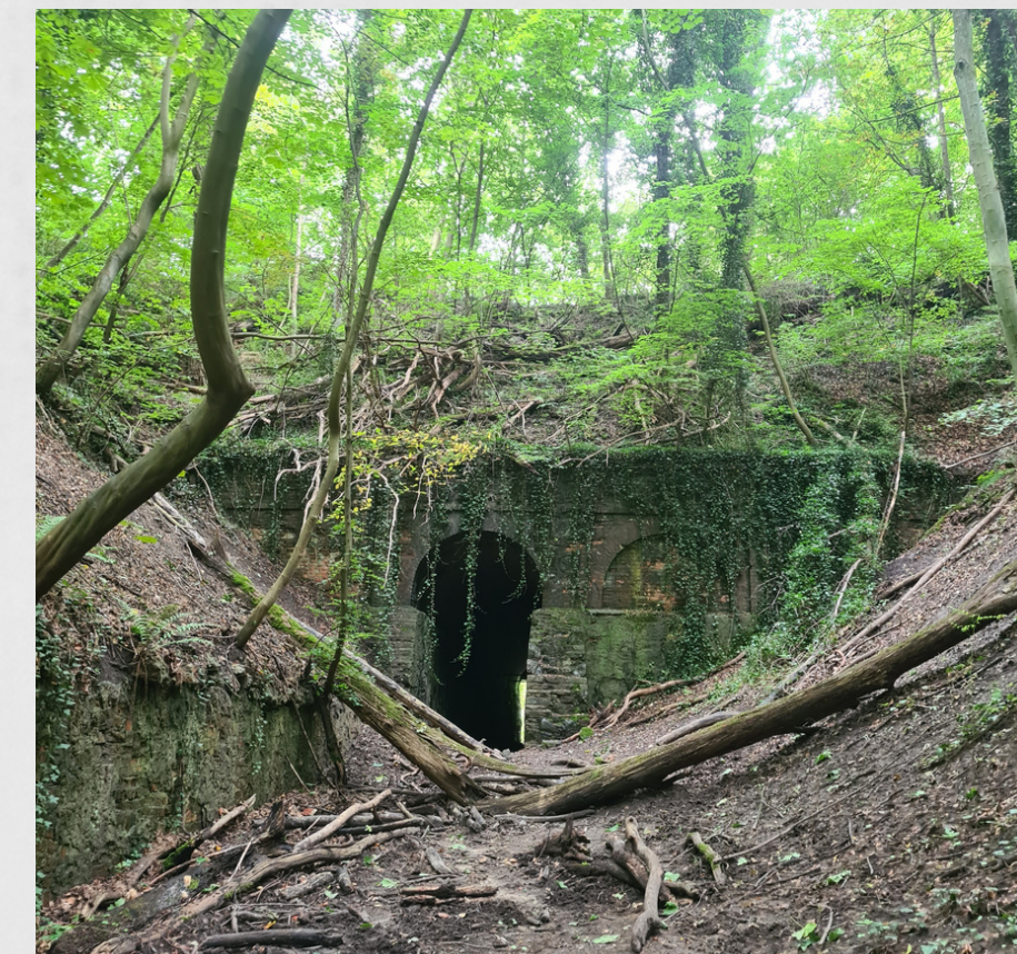
Tunel kolejki w starej kopalni
